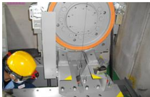
巻き上げ機の芯だし (中心の位置決め) を行います。
