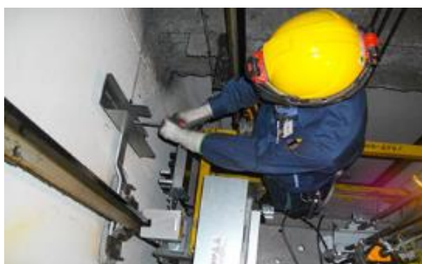
着床プレートを取り付けます。
