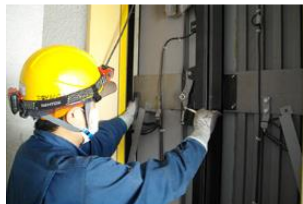
カゴ扉 (エレベーターの扉) まわりの機器を取り付けます。
