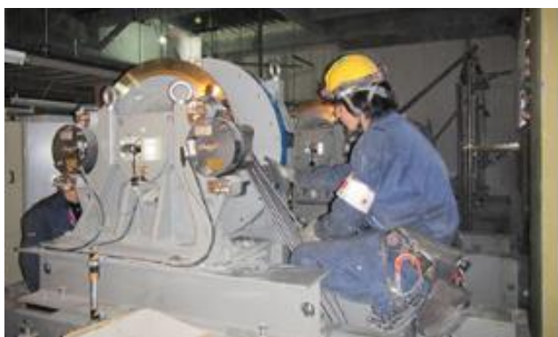
新しい巻き上げ機を設置しました。
