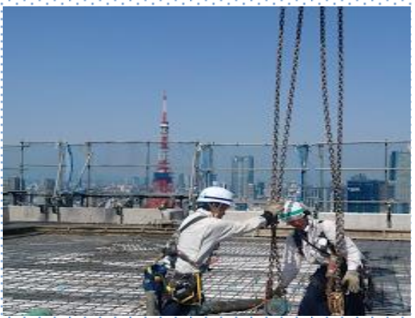
・タワー・クレーンでの作業現場の様子
