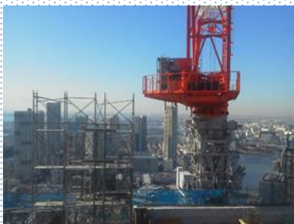
地上 150m 付近のタワー・クレーンと足場
