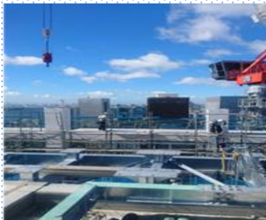
・東京湾に面する作業現場の様子
