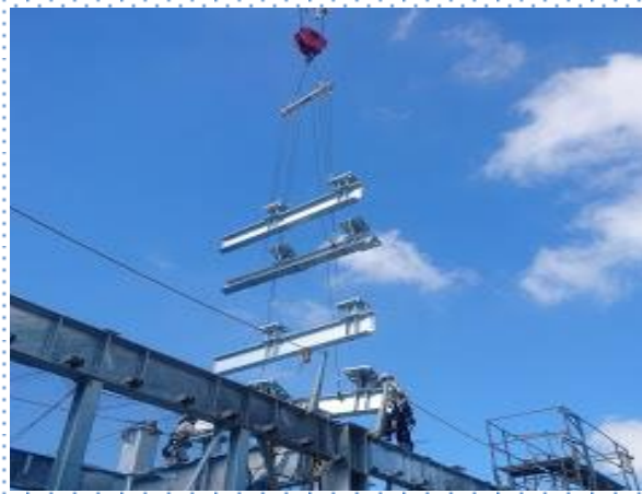
・鉄骨組立工事の作業現場の様子
