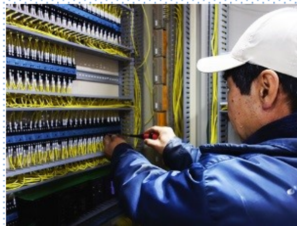
制御盤製作の様子
