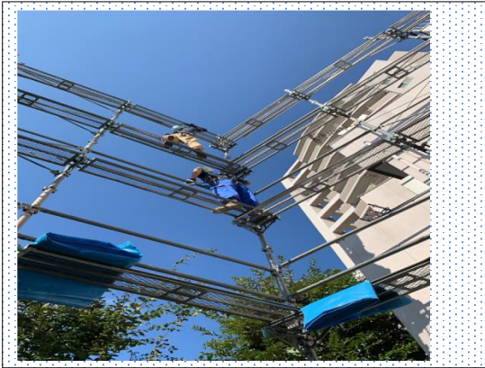
作業現場の様子①
