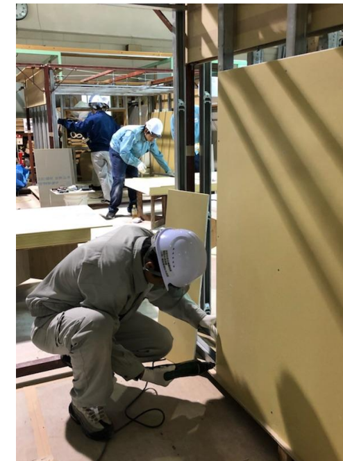
「石膏ボード張り」
