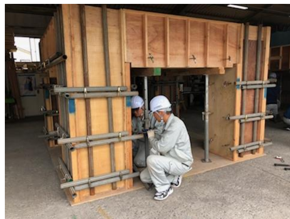
「型枠組み立て」
