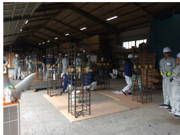
「鉄筋組み立て」
