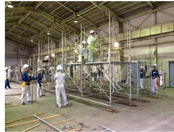
「足場組み立て」
