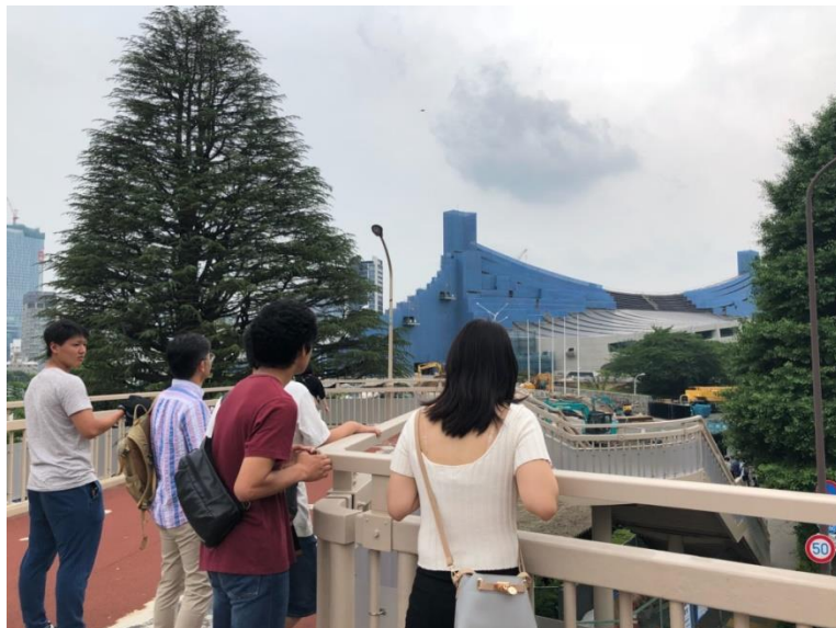
改修工事中の国立代代木競技場
