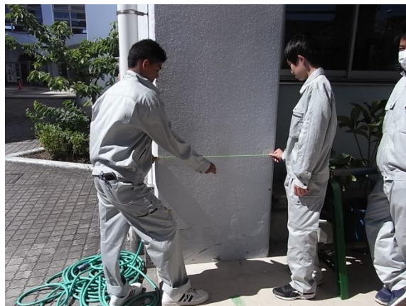
高さ1 mの測設
