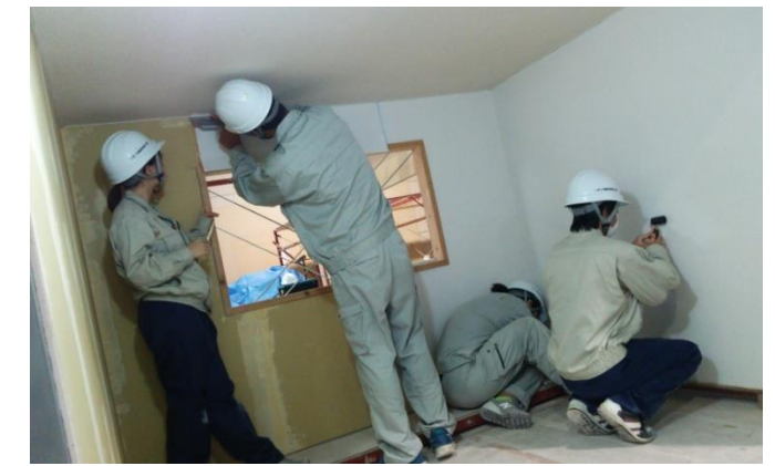
「内装クロス張り（開口部）」
