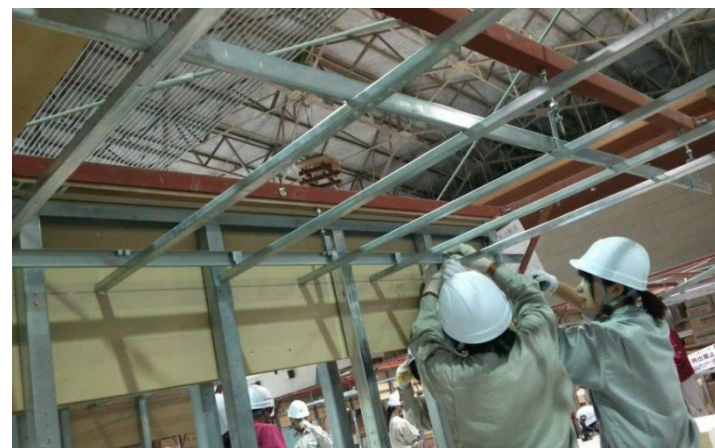
「鋼製下地の取り付け」
