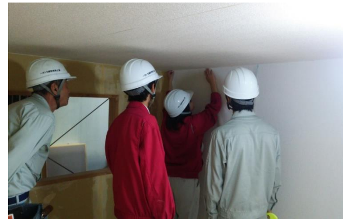
「内装クロス張り（壁）」
