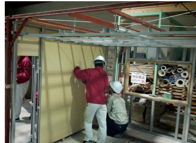
「壁・天井ボード貼り」
