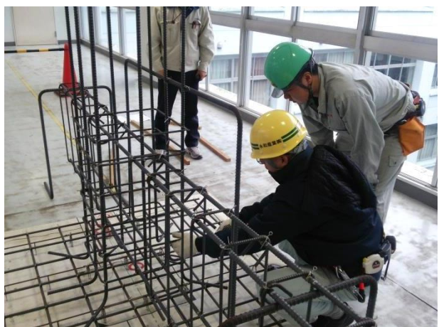
梁筋の施工方法の指導
