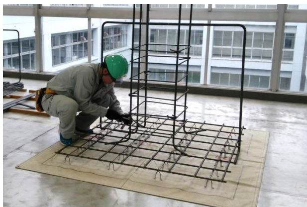
ベース筋・柱筋の施工
