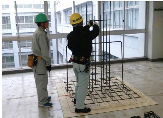
柱筋の建て入れ調整
