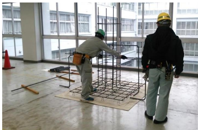
梁筋の施工
