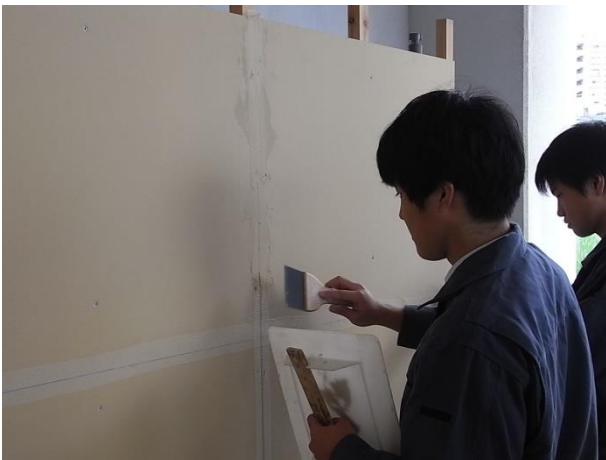
ジョイントテープ・パテ処理
