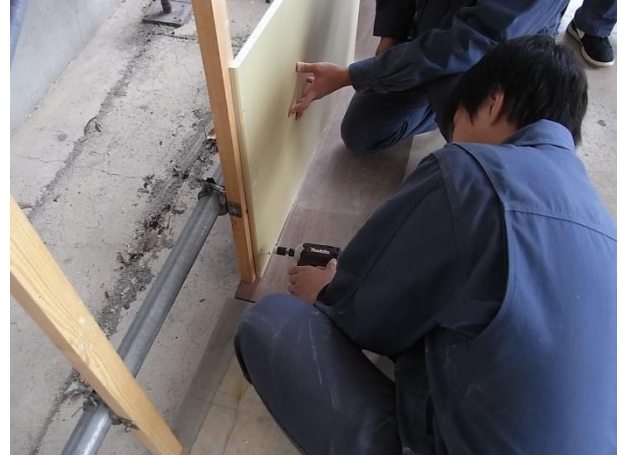
石膏ボード取り付け
