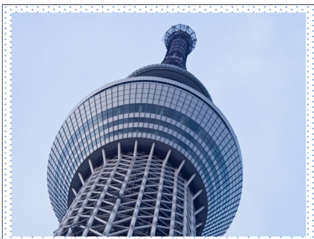
施工実績 : 東京スカイツリー展望台
