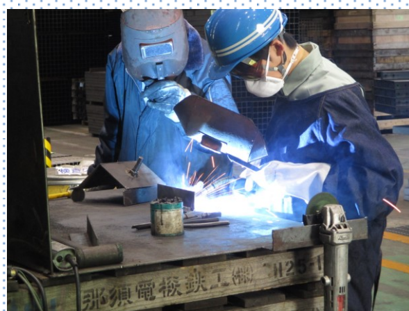
溶接作業の様子
