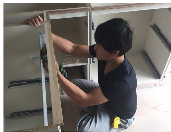
作業現場の様子①
