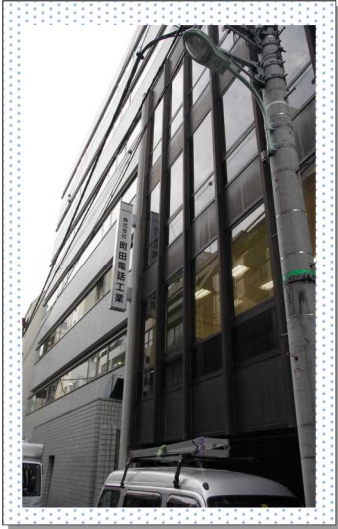
日本橋事業所の外観です。5F 建てのビルです。
