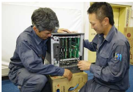
電話機の設定作業です
