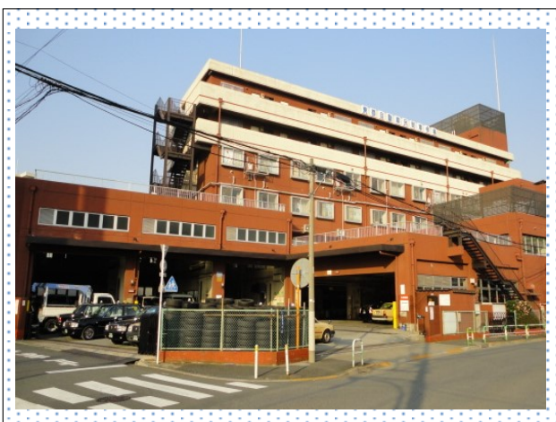
浮間本社全景
