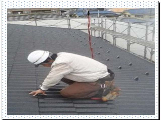
作業現場の様子①
