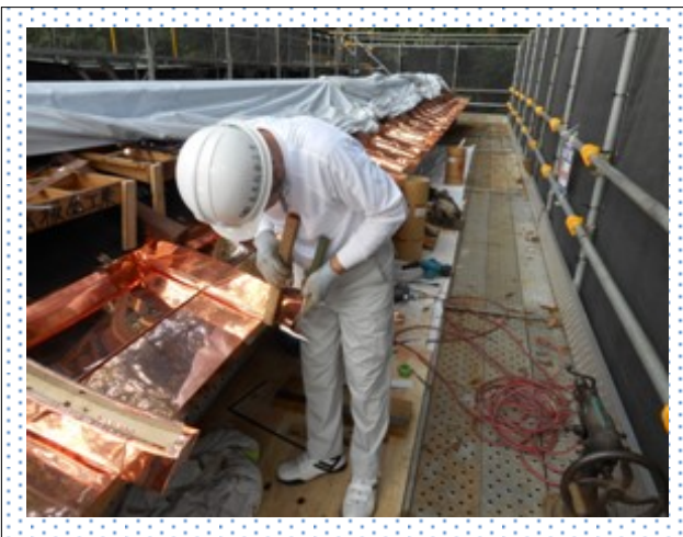
作業現場の様子②
