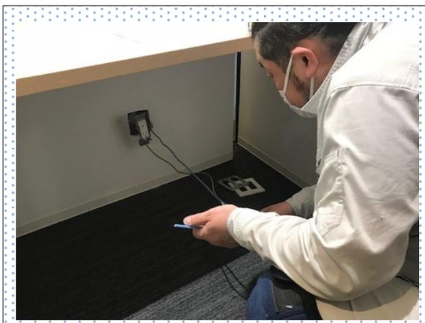
作業現場の様子②【壁埋込コンセントの設置】
