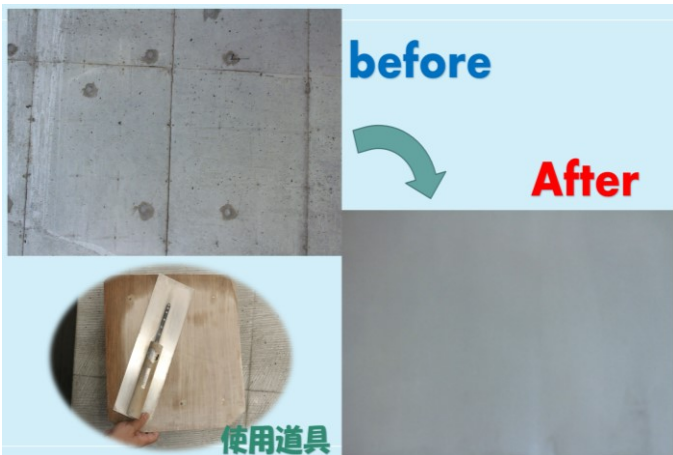
作業前と作業後の吹付け下地 主な使用道具は鏝(こて)と鏝板(こていた)です。
