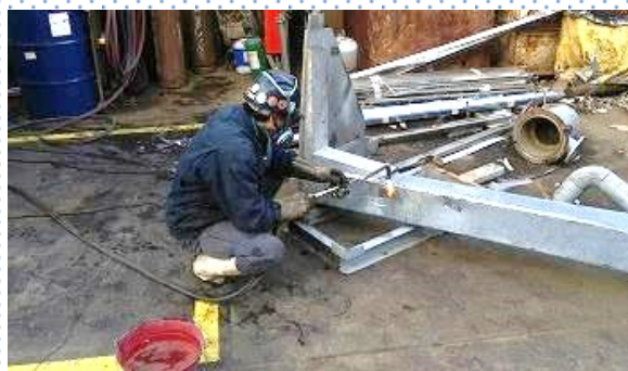
鉄くずをガスで溶断しているところ
