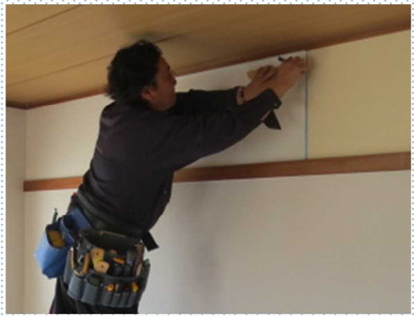
クロス工事作業の様子
