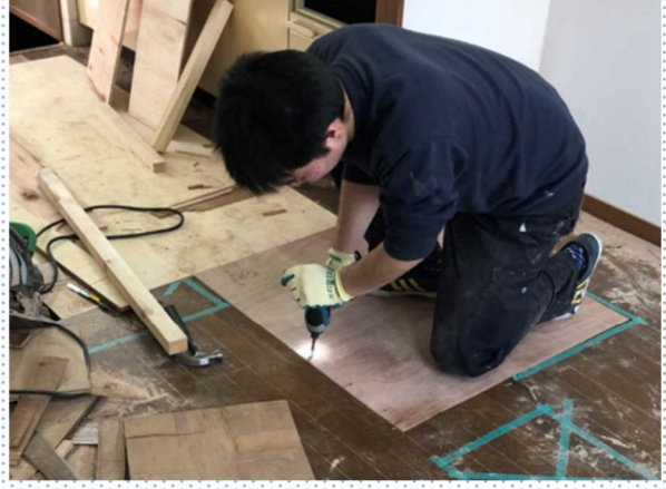
床工事の様子
