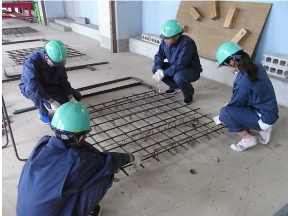
基礎部分の組立
