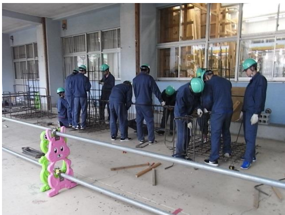
梁部分の組立
