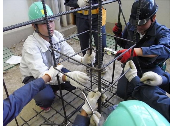
柱部分の組立
