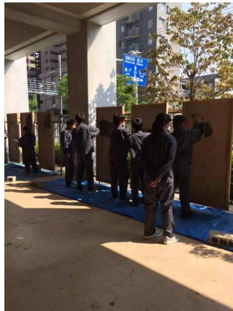
壁モルタル塗②
