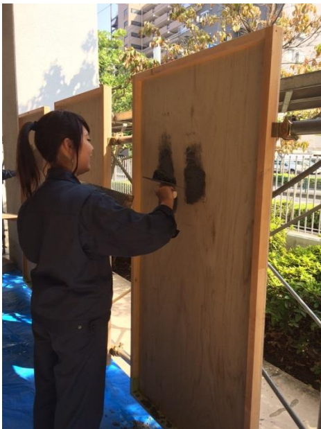
壁モルタル塗①
